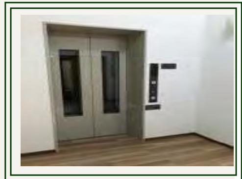
エレベーター
